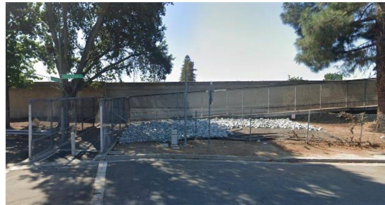
Puente sobre la autopista I-280 en Cypress Avenue en San José Fuente: Google Streetview
